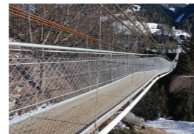
Hängebrücke zwischen Ernen und Fürgangen, 2015
